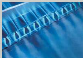
Режим «Soft» - распределение воздуха через микро-поры
